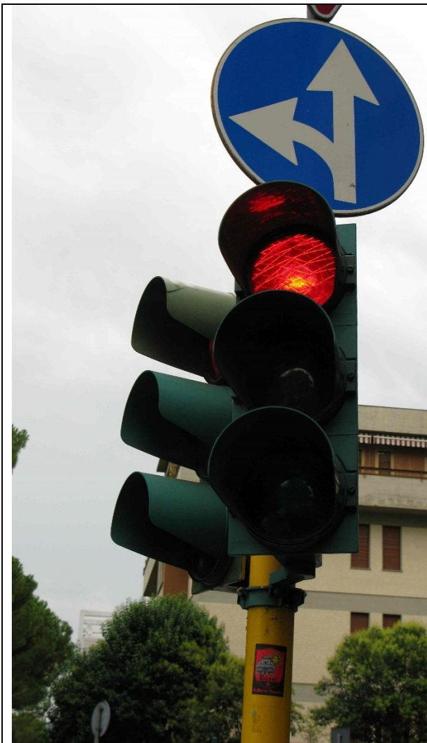
Lanternasemaforica veicolare su palina
