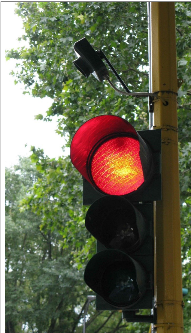
Lanternas veicolare con rosso maggiorato Ø 300 mm ed avvisatore acustico per non vedenti
