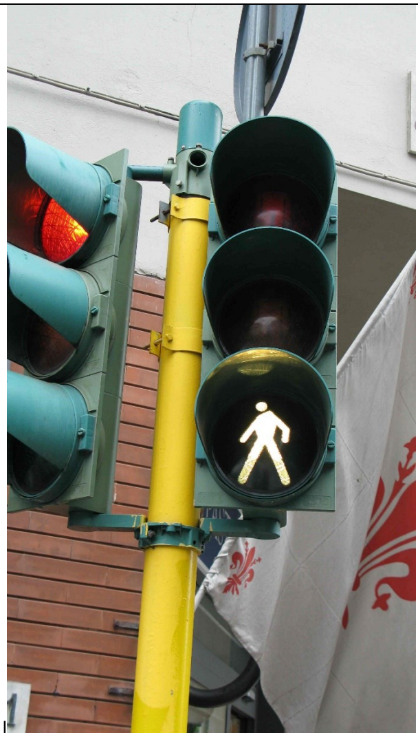
Lanternasemaforica pedonale su palina
