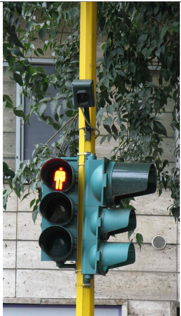
Lanternas semaforica pedonale con avvisatore acustico per non vedenti
