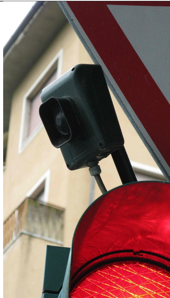
Dettaglio di avvisatore acustico non vedenti
