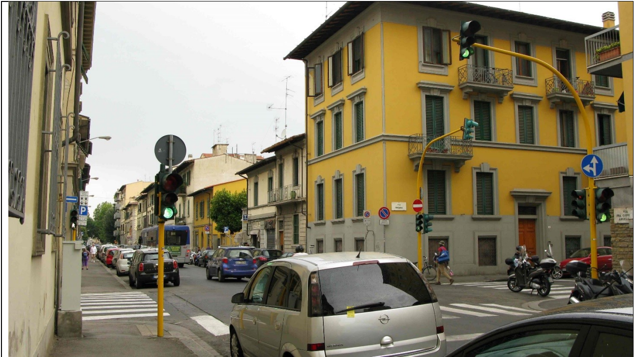
Vista panoramica di incrocio tipico con presenza di lanterne semaforiche alte su pali a sbraccio
